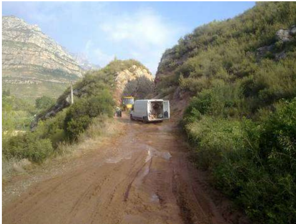
Obres de reparació del tub per la fuga de setembre de 2011
